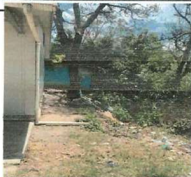
Foto 3: Mejoramiento de Baño Lavable
