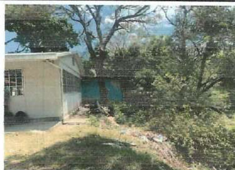
Foto 4: Mejoramiento de fosa séptica
