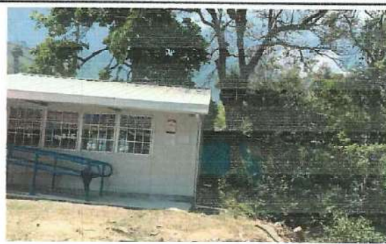
Foto 2: Mejoramiento Muro perimetral parte posterior del establecimiento
